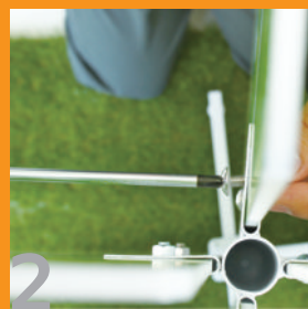
2 本体とパネルをボード 固定ビスで固定します。
